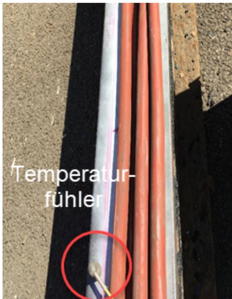
Abb. 20-1: Temperatursensor auf Fahrkopf
