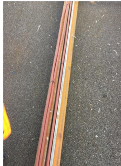
Abb. 20-2: verlegte Induktionsschleifen in einer Flachrille zum Vorwärmen
