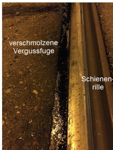
Abb. 03-2: Nach dem Schweissen wieder verschmolzener Fugenverguss
